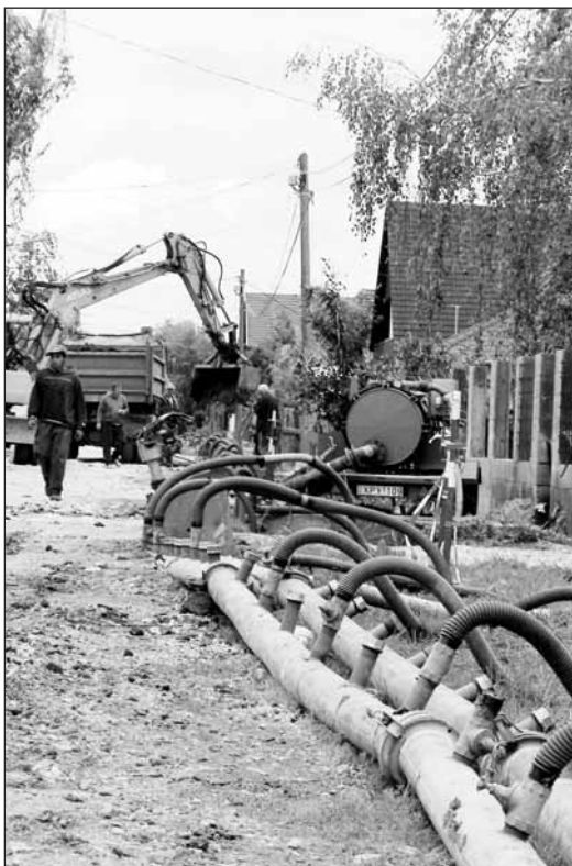
Munkában a szivattyúk. A csatornázás megkezdésének alapfeltétele volt a talajvíz szintjének csökkentése. Ezt több, mint 30 nap szivattyúzással az akkori 80 cm-es magasságról átlagosan 250-300 cm mélységűre csökkentették!
